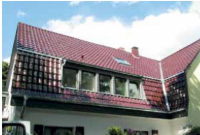
Optik und Zweckmäßigkeit in idealer Weise verbunden: Hier wurde das alte Material bis auf die Dachsparren abgetragen und durch das System aus Auf- und Zwischensparrendämmung ersetzt. Tonziegel mit leichter Glasur (Farbe Rotbuche) unterstreichen die Aufwertung des Hauses.
