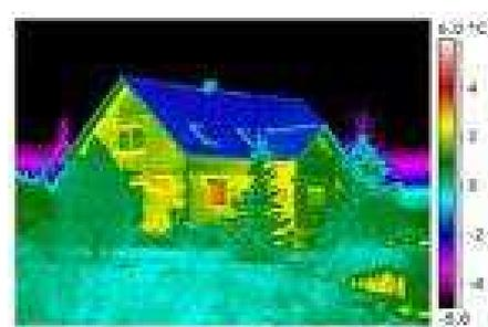
Auch im Fassadenbereich können Sie sehen, wie viel Wärme über die Außenhülle verloren gehen kann und wie stark sich ein nicht gedämmter Kamin in diesem Fall als Wärmebrücke auswirken kann.
